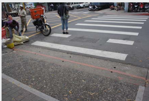
圖 4 行穿線對應處開設無障礙斜坡道(攝於臺北市榮星花園)
