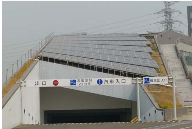
圖 3 大寮機廠管理中心 (A) 斜坡設置太陽光電模板 (草皮屋頂型式)
