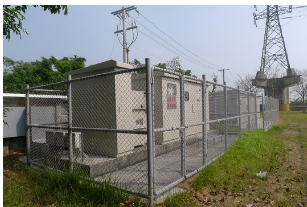
圖 8 大寮機廠太陽光電發電系統與台電公司（TPC）併聯點
