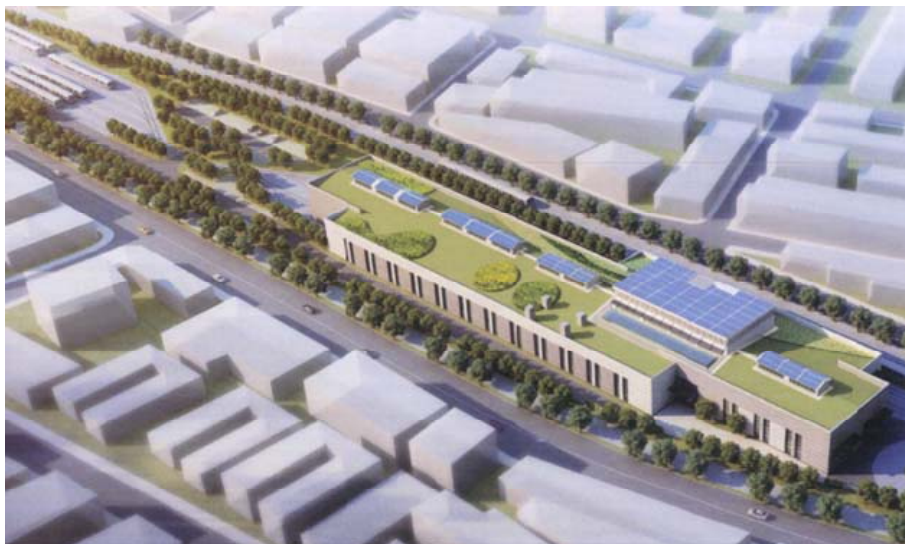
圖 12 高雄環狀輕軌捷運機廠屋頂設置太陽光電發電系統概圖
