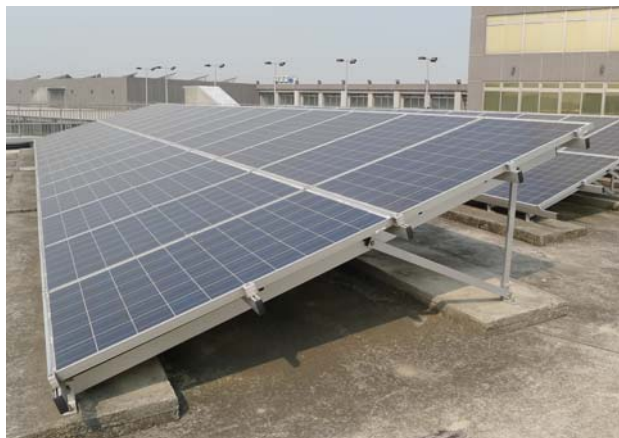
圖 4 大寮機廠員工活動中心 (A) 斜坡設置太陽光電模板 (混凝土屋頂型式)
