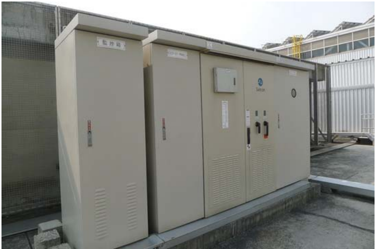
圖 2 100KVA 直/交流轉換器、直流總盤箱
