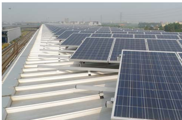
圖 7 大寮機廠底盤清洗場（G）屋頂設置太陽光電模板（鐵皮屋頂型式）
