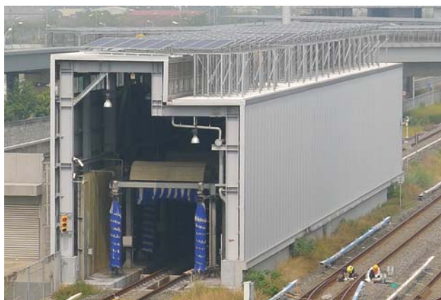
圖 6 大寮機廠洗車場（F）屋頂設置太陽光電模板
