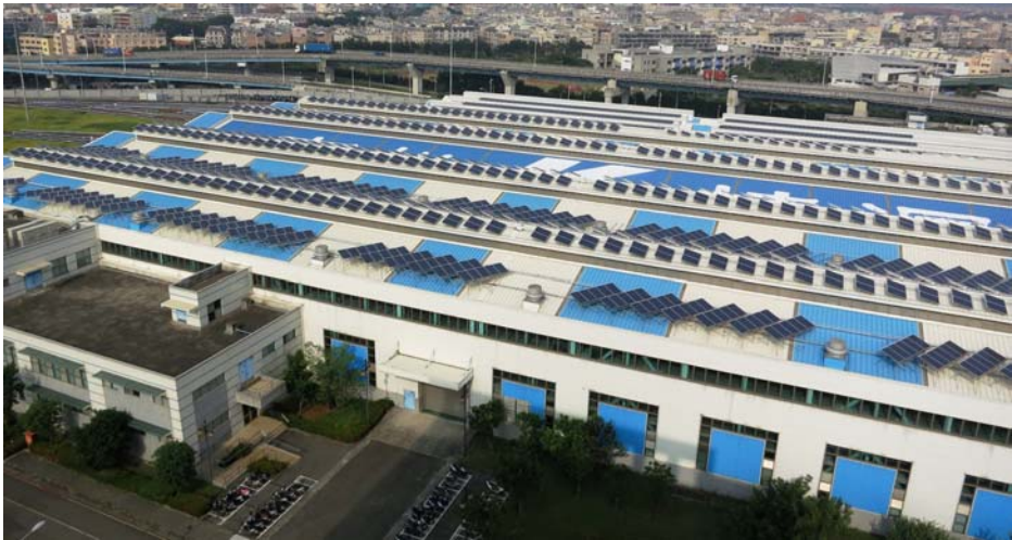
圖 9 南機廠維修工廠 (A) 及駐車區 (B) 屋頂設置太陽光電模板
