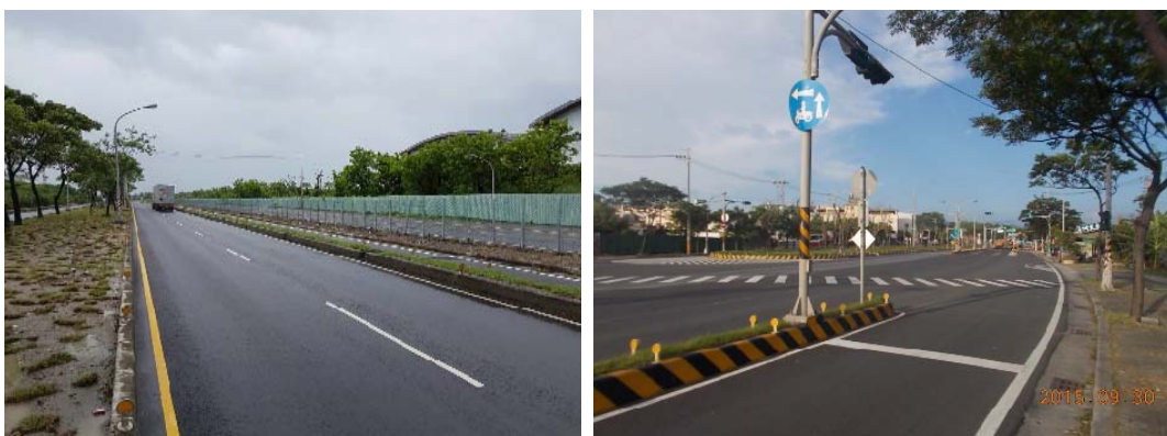
圖11 高雄市南星路應用轉爐石於瀝青混凝土鋪面
