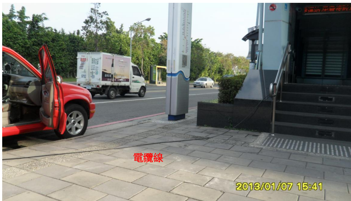
圖 6-7 模式一電纜線延伸至地下場站實景
