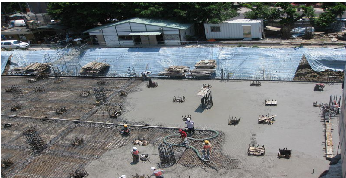
圖 2-2 筏基頂版 RC 澆置實景圖
