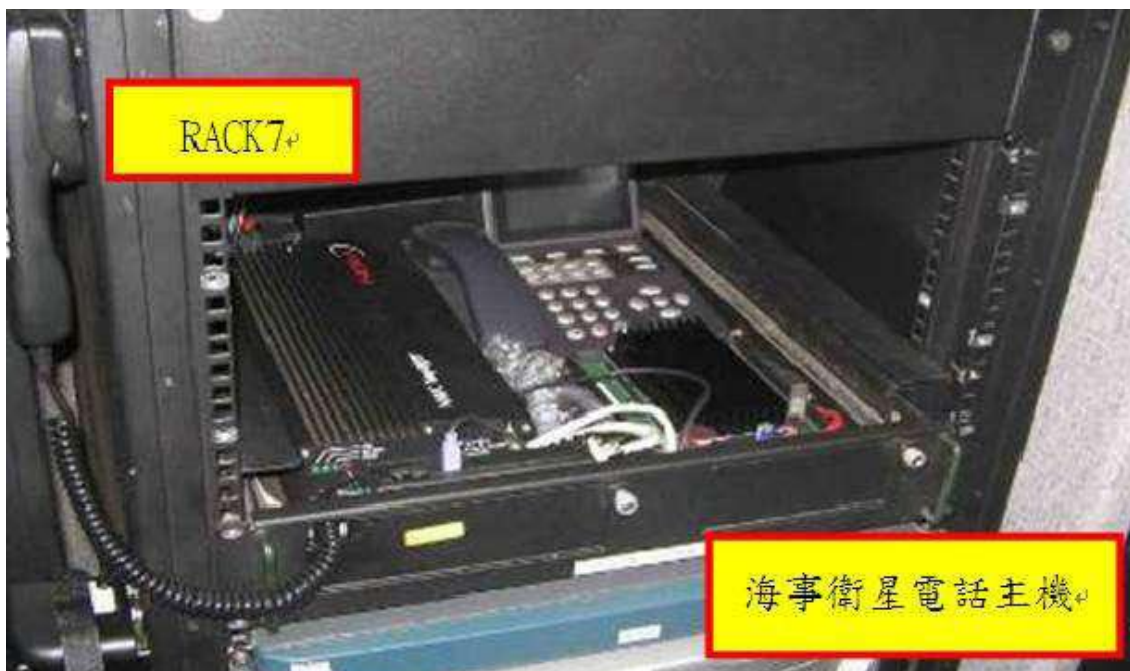
圖 3-12 海事衛星行動電話主機示意圖
