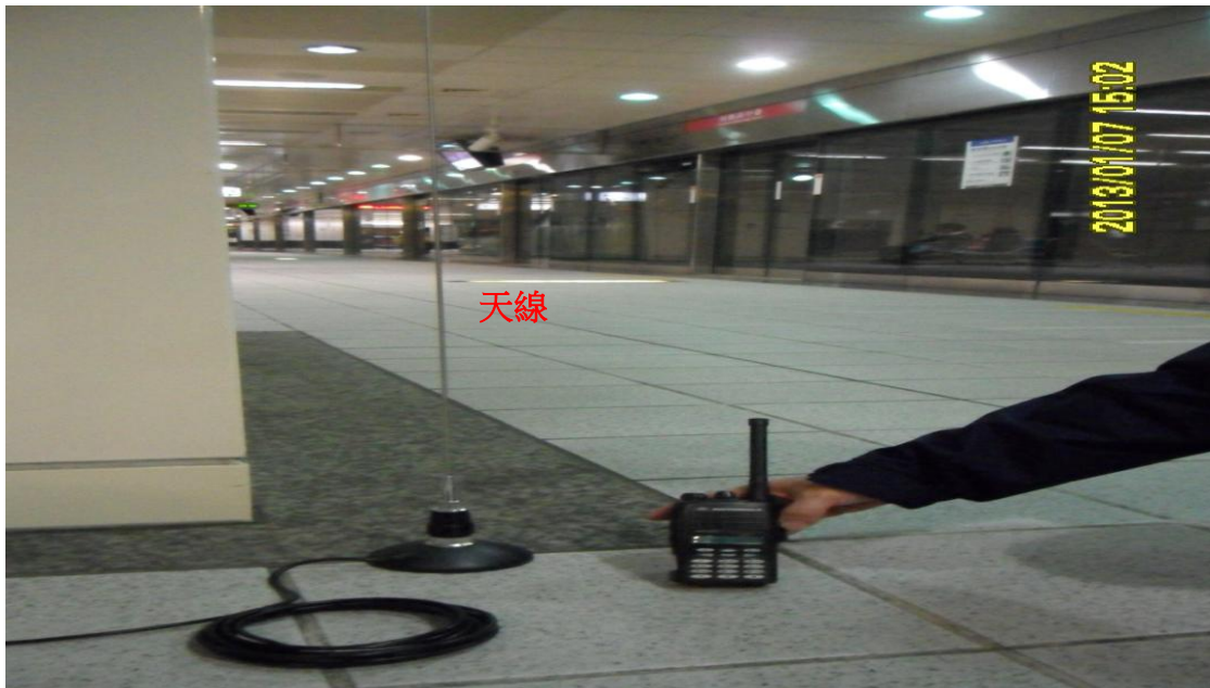
圖 6-8 模式一電纜線延伸至地下場站架設天線實景
