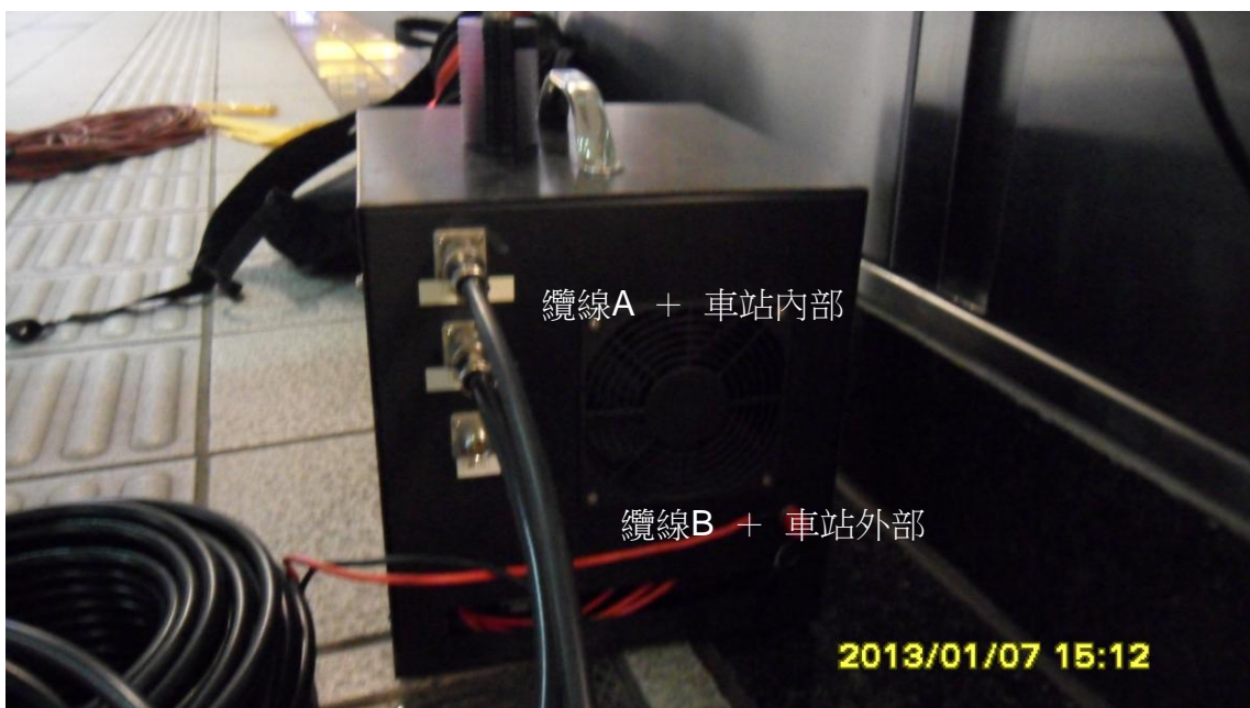
圖 6-15 模式二無線電轉播機與電纜線連接實景
