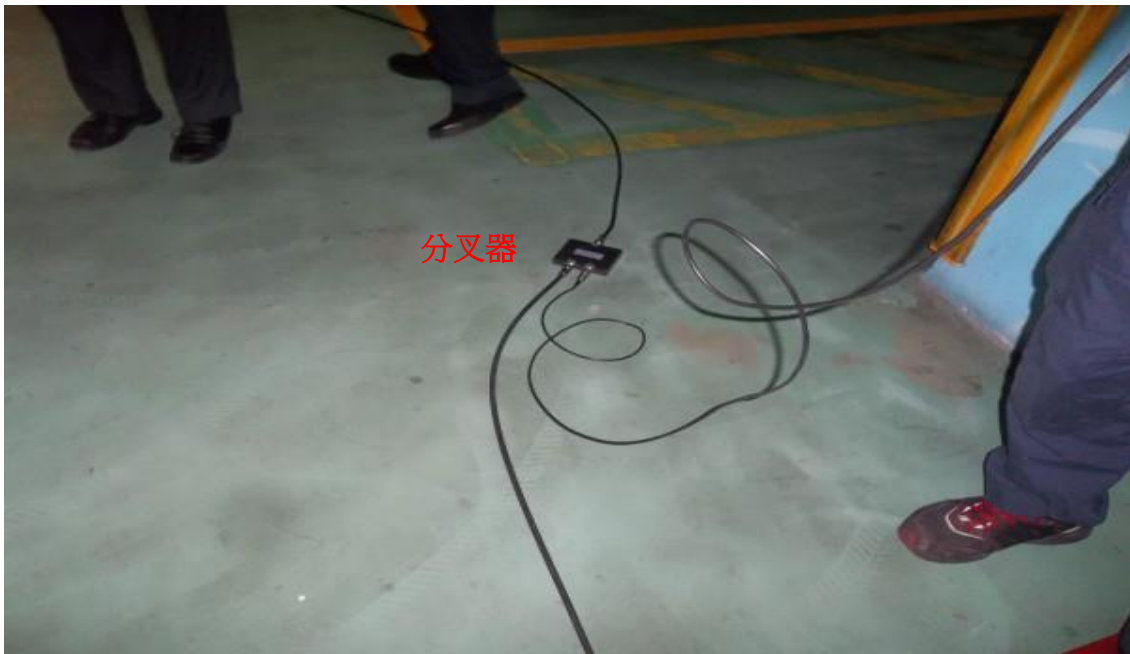
圖 6-20 電纜線分岔延伸各地下樓層測試實景 (一)
