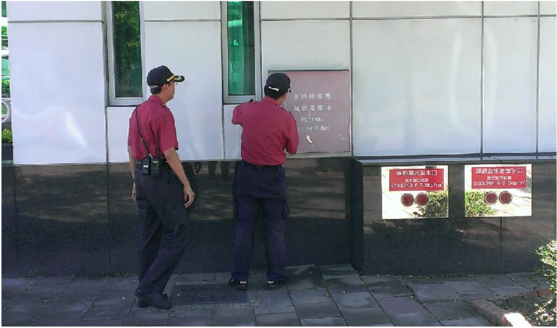
圖 4-4 高雄捷運消防無線電界面箱 (一)
