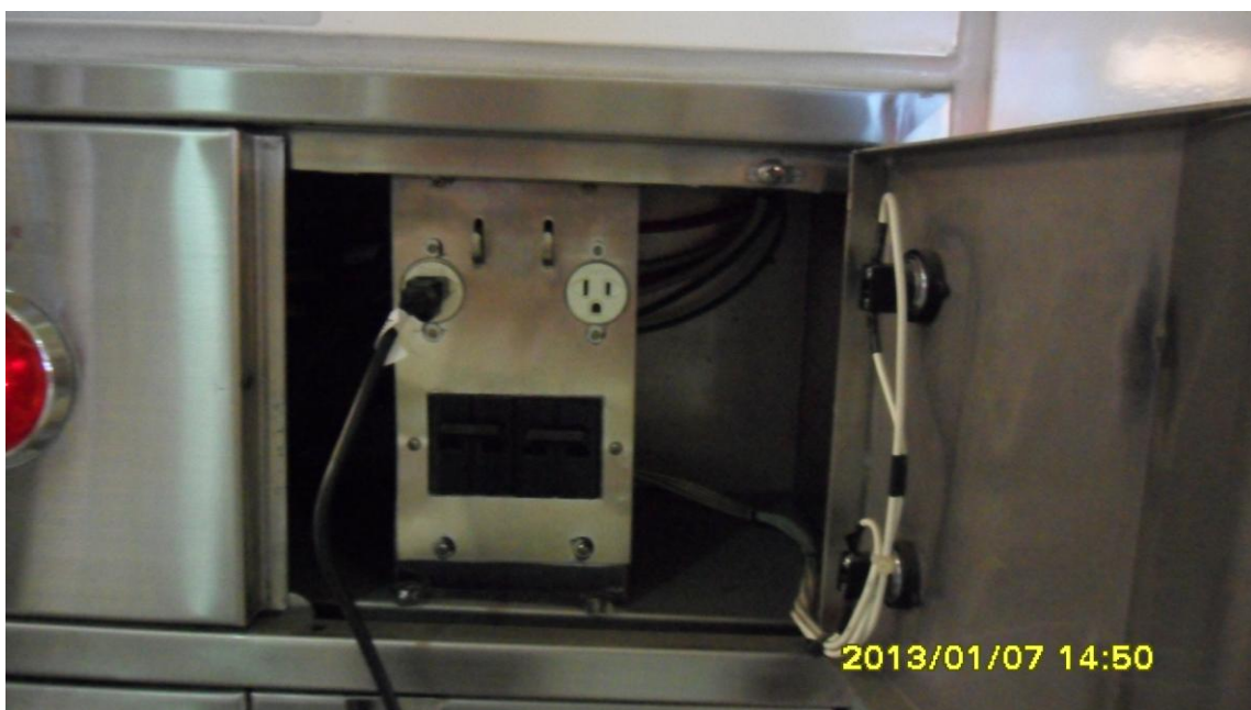
圖 6-13 模式二無線電轉播機連接緊急電源測試實景
