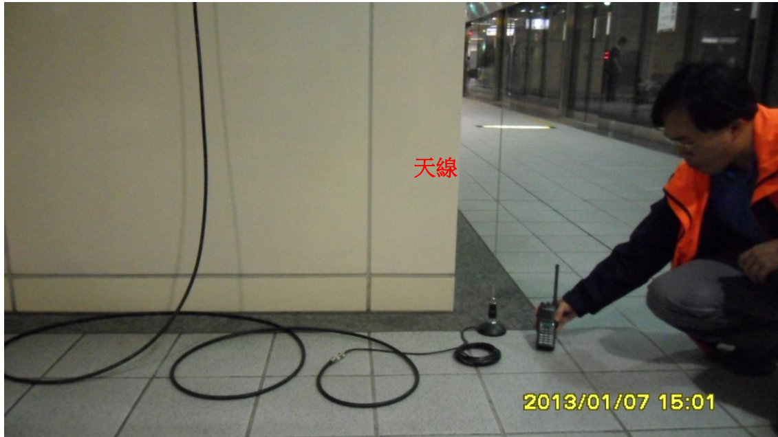
圖 6-16 模式二纜線 A 架設天線測試實景
