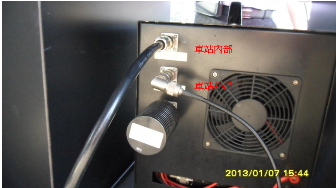
圖 6-6 模式一無線電轉播機與電纜線連接實景
