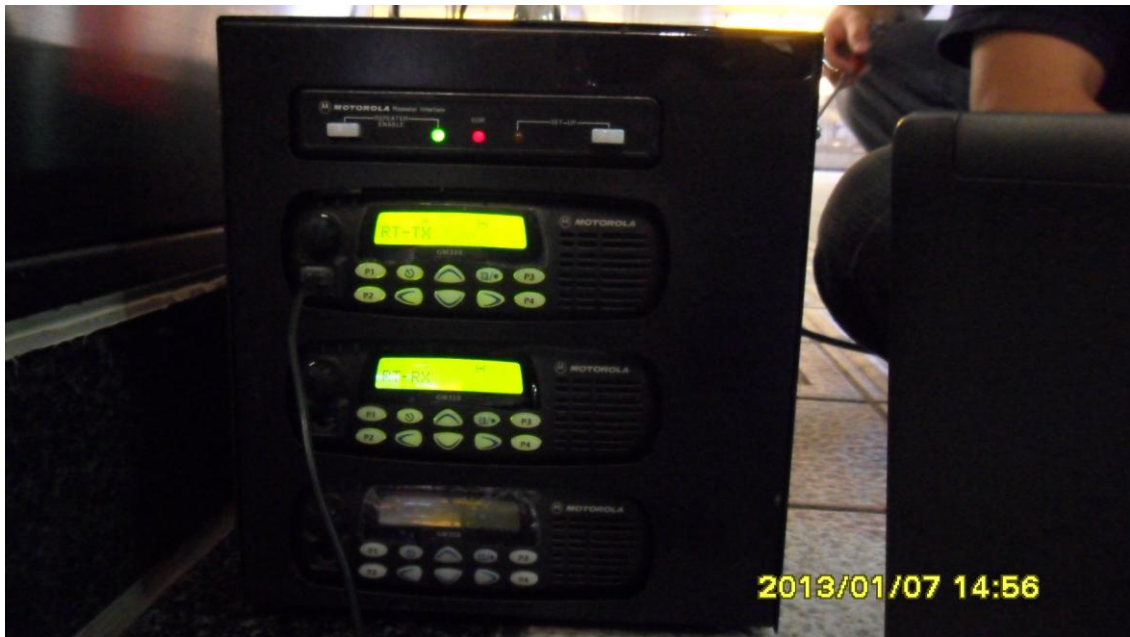
圖 6-12 模式二無線電轉播機移置地下場站測試實景
