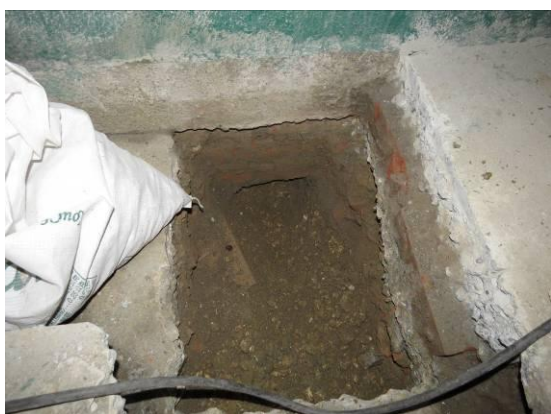
照片 2-21 試掘後呈現之混凝土基座
