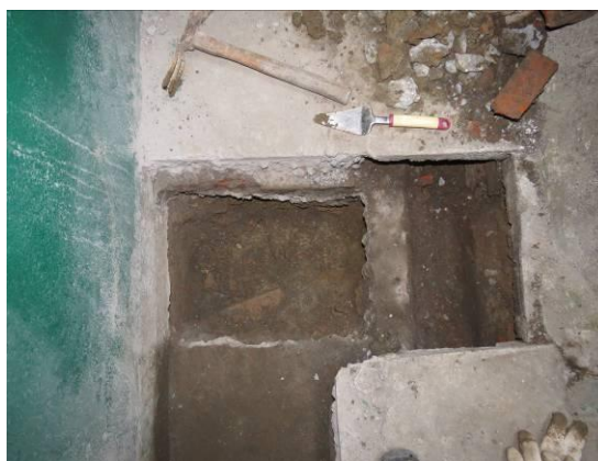
照片 2-22 試掘後呈現之原犬走及排水溝
