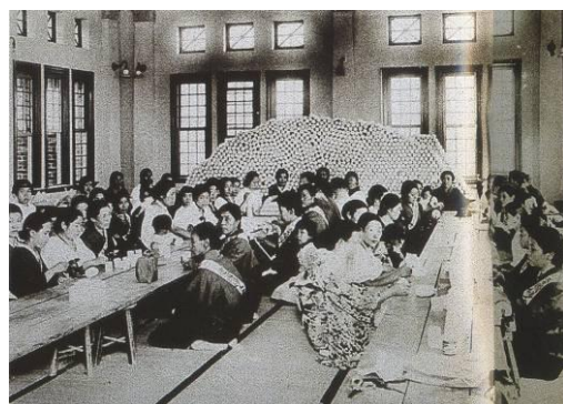
照片 3-52 舊照片之原上下拉窗之窗櫺分割為格子狀，迴轉窗為「米」字分割。
