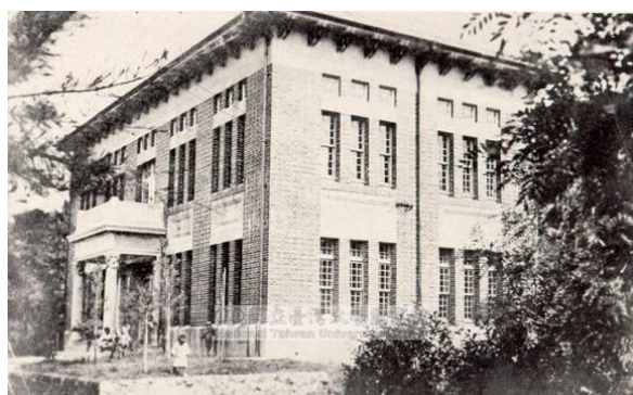
照片 3-52 舊照片之原上下拉窗之窗櫺分割為格子狀，迴轉窗為「米」字分割。
