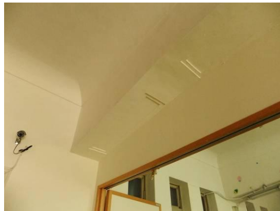
照片 3-44 一樓與二樓間鋼筋混凝土樑及樓板
