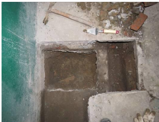
照片 3-37 地坪試掘後呈現之原犬走地坪及排水溝
