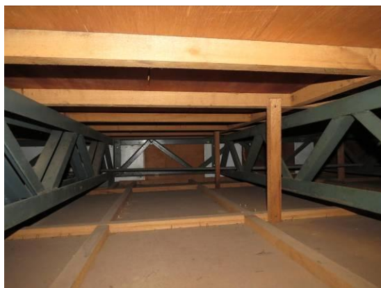
照片 3-45 二樓與夾層間天花板孔洞 照片 3-46 二樓與夾層間鋼桁架
