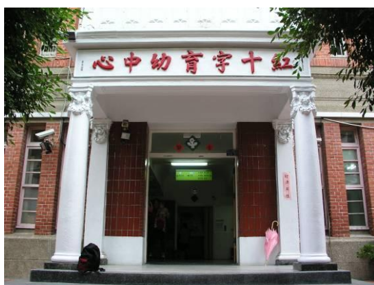
照片 3-40 門廊獨立柱及附壁柱
