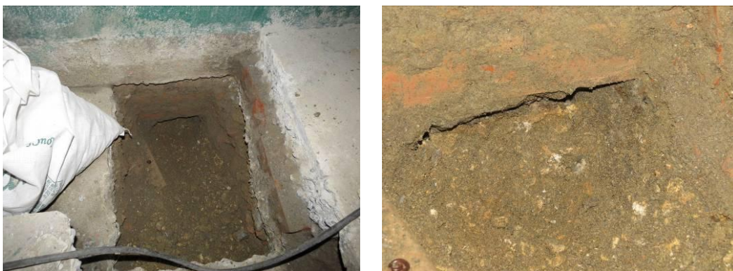
基座混凝土打除後並無磚造放腳基腳
