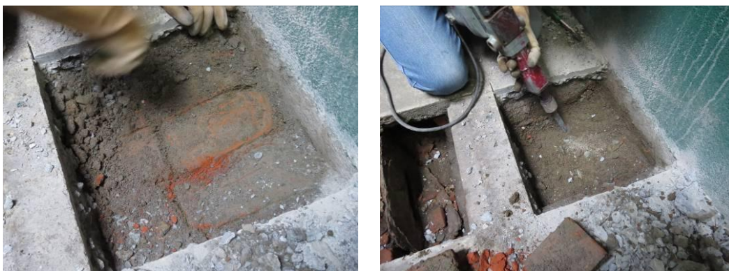
底層鋪磚(23*11*6cm)及原犬走粉刷層(花崗石+水泥砂漿)打除
