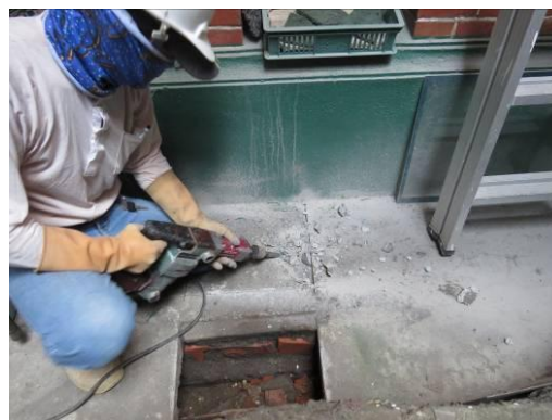
試掘範圍地坪切割及表層混凝土打除
