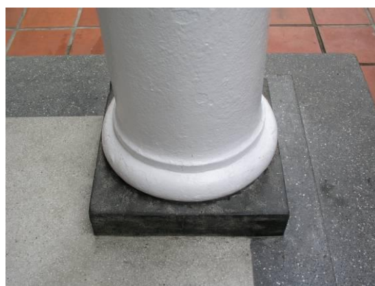
照片 3-41 方形柱座及圓形柱基
