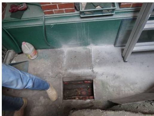
試掘範圍地坪切割及表層混凝土打除
