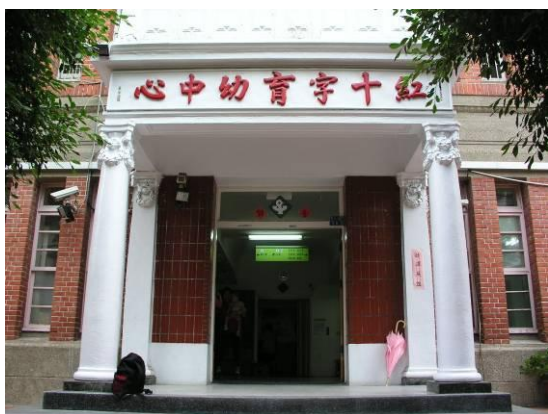
照片 3-74 門廊獨立柱及附壁柱
