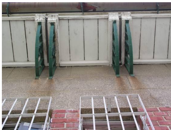
照片 3-73 一樓台基及二樓頂帶之洗石子面分割有仿石砌牆面之意圖
