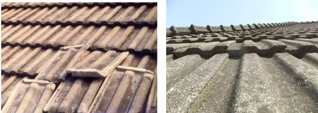
照片 3-69 初創期圓形斷面黑色德式瓦 照片 3-70 第二期方形斷面灰色水泥瓦
