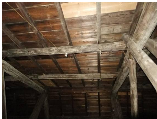
照片 3-88 屋架內舊電力配線及礙子
