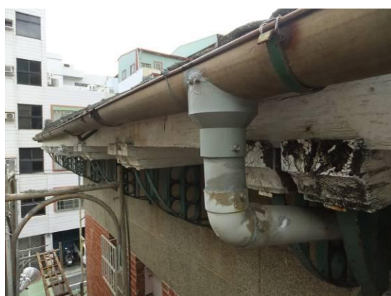
東側屋頂天溝及落水管接合處現況
