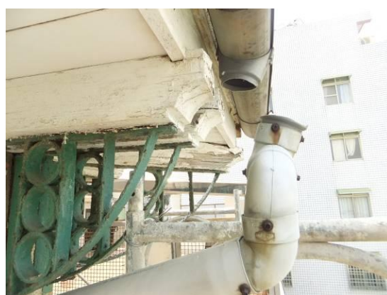
南側屋頂天溝及落水管接合處現況
