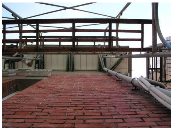
照片 3-92 落水管及鐵件
