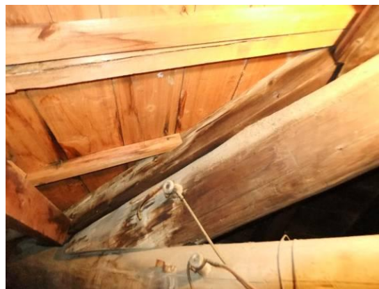
照片 3-88 屋架內舊電力配線及礙子
