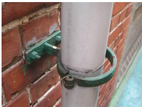
照片 3-92 落水管及鐵件
