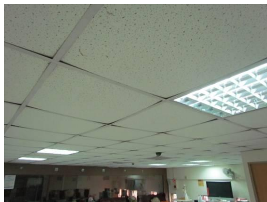
照片 6-40 增建夾層輕鋼架礦纖天花板
