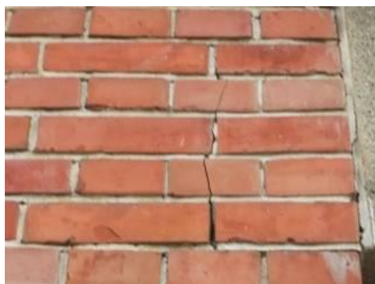
照片 6-18 正立面中央紅磚斷裂
