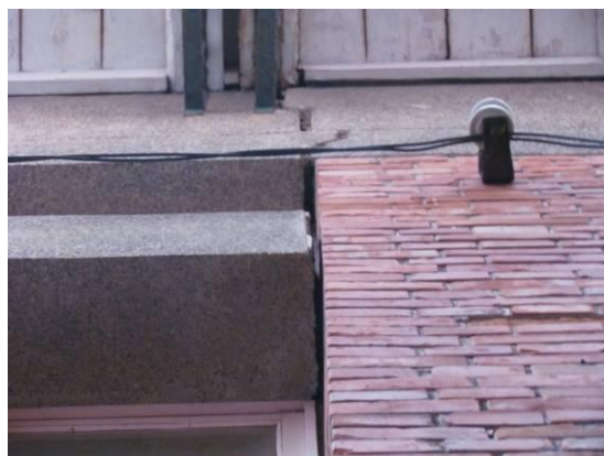
照片 6-19 右側立面中央前端長窗周邊 牆體垂直開裂嚴重
