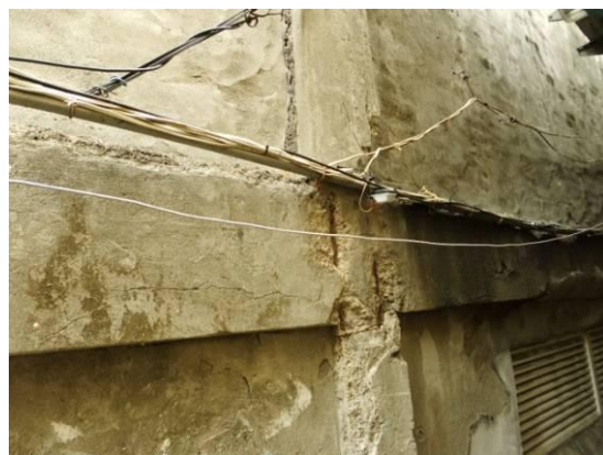
照片 6-87 局部粉刷剝落造成鋼筋外露
