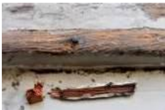
照片 6-58 正面窗框構材風化現象(2)： 木材粗糙
