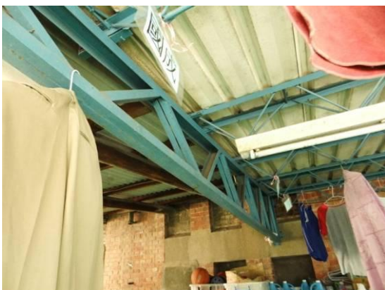
照片 6-100 金屬桁架現況-1
