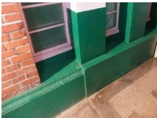
照片 6-3 背立面基座中央水泥粉刷表面 上漆、兩側為洗石子表面上漆
