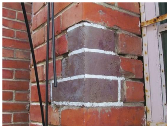
照片 6-14 仿紅磚修補色澤與原貌差異過大
