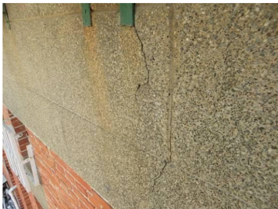
照片 6-35 外牆洗石子粉刷龜裂
