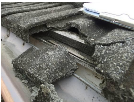
照片 6-51 屋瓦老化破裂
