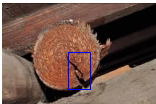
新杉木母屋構材之單心裂開裂現象 (含樹皮)
