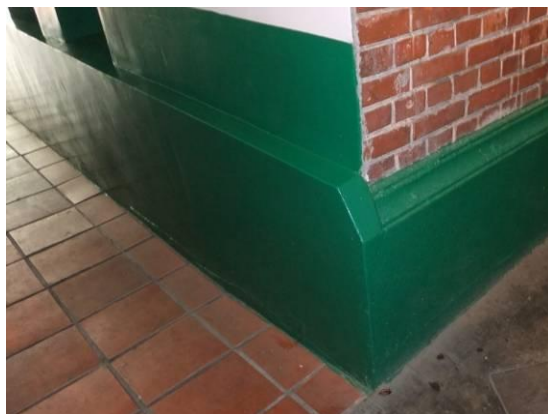
照片 6-4 左側立面基座水泥粉刷上漆
