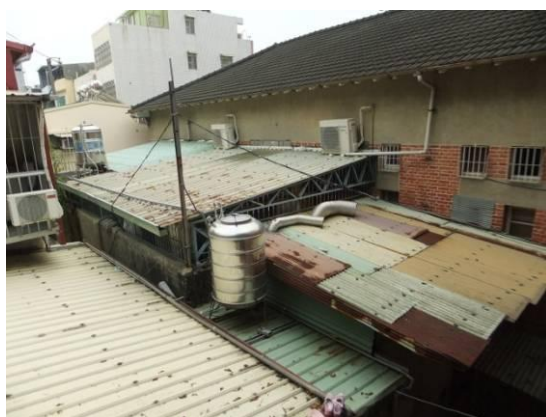
照片 6-95 鋼浪板屋頂損壞現況-1
