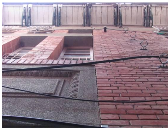
照片 6-20 右側立面由檐口延伸至一、二樓交界處有垂直開裂
