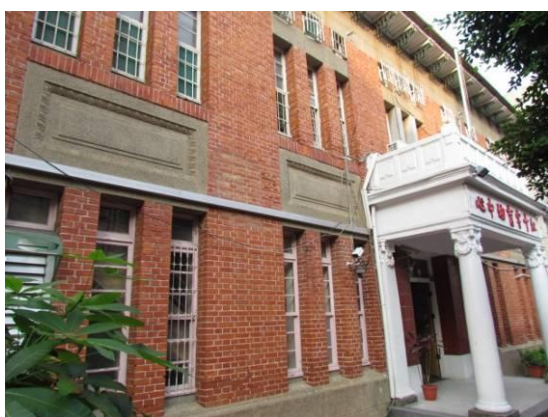
照片 6-27 外牆磚面及洗石子粉刷
