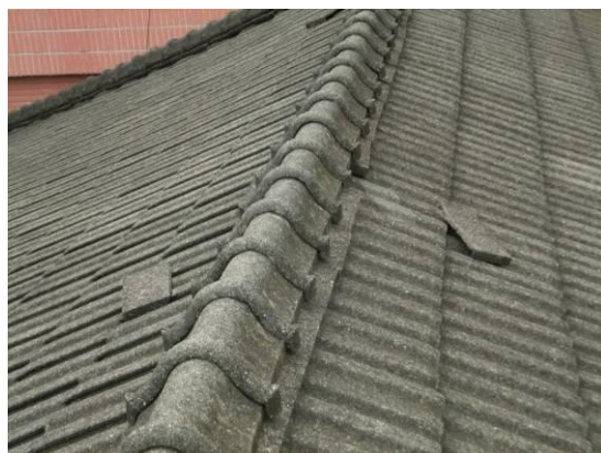
照片 6-48 中脊壓帶瓦掉落
