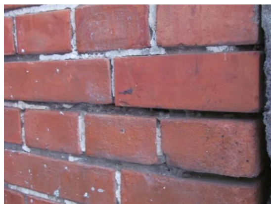
照片 6-17 灰縫脫落佚失
