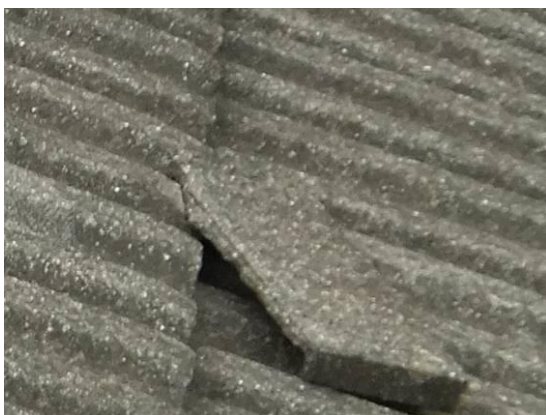
照片 6-49 壓帶瓦無孔洞以綁紮銅線
