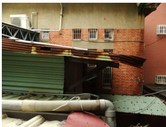
照片 6-97 鋼浪板生鏽破洞
