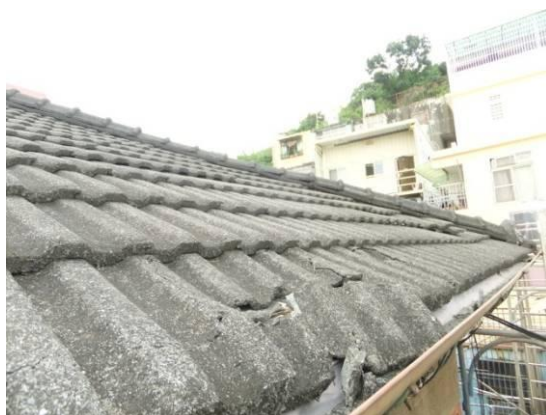
照片 6-50 屋瓦老化破裂、髒垢附著
