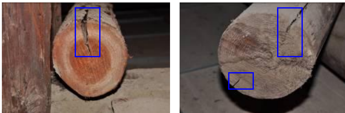
新杉木受釣木構材之開裂現象(含樹皮) 舊杉木受釣木構材之開裂現象(未含樹皮)
