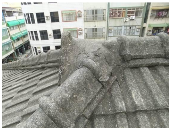
照片 6-52 鬼瓦損壞以水泥修補
