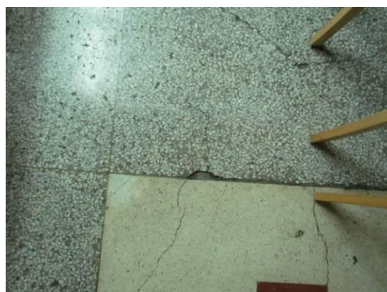
照片 6-8 磨石子地坪局部剝落缺損
