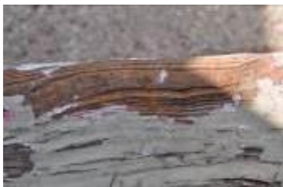
照片 6-57 正面窗框構材風化現象(1)： 木材年輪凹凸不平
