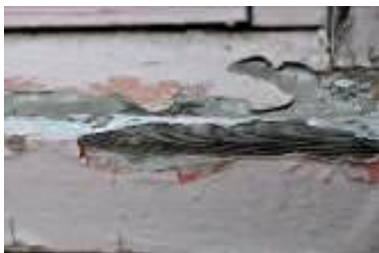
照片 6-59 正面窗框構材風化現象(3)： 油漆層脫落
