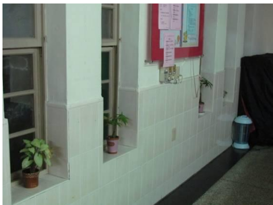
照片 6-31 上半部水泥粉刷表面上漆 下半部磁磚鋪貼
