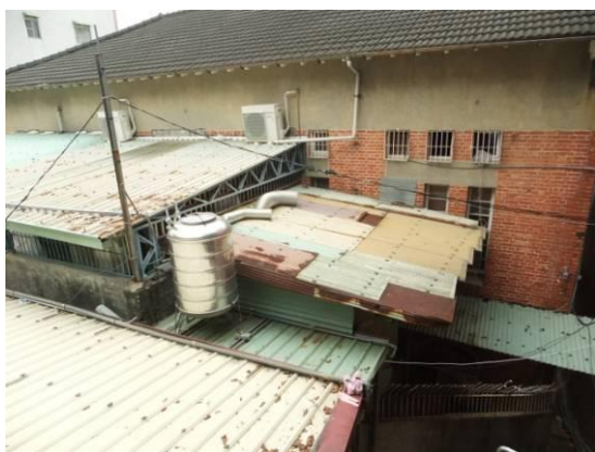
照片 6-96 鋼浪板屋頂損壞現況-2
