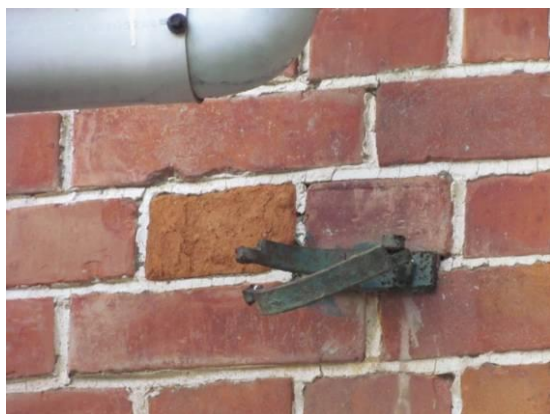
照片 6-13 紅磚風化及缺角損壞
