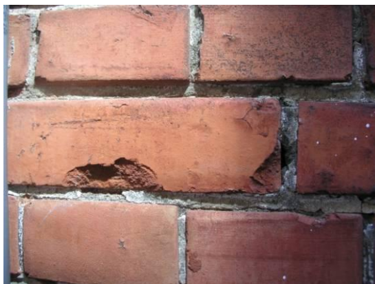
照片 6-16 磚面破損
