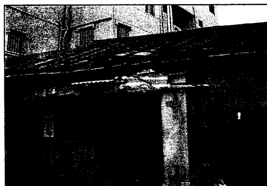
圖3-4-20 右昌地區衰頹傳統建築
