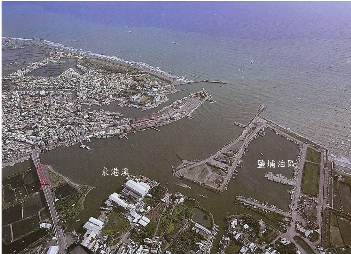
圖 4.1-9 東港鹽埔漁港空照圖
